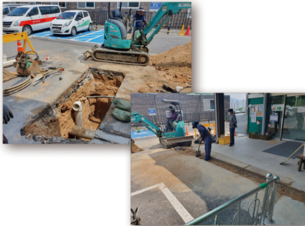
한국SMC, 고영현 후원자님께서 보내주신 지정후원금을 사용하여 주방 하수구 배관 개선 공사 를 진행했습니다.
